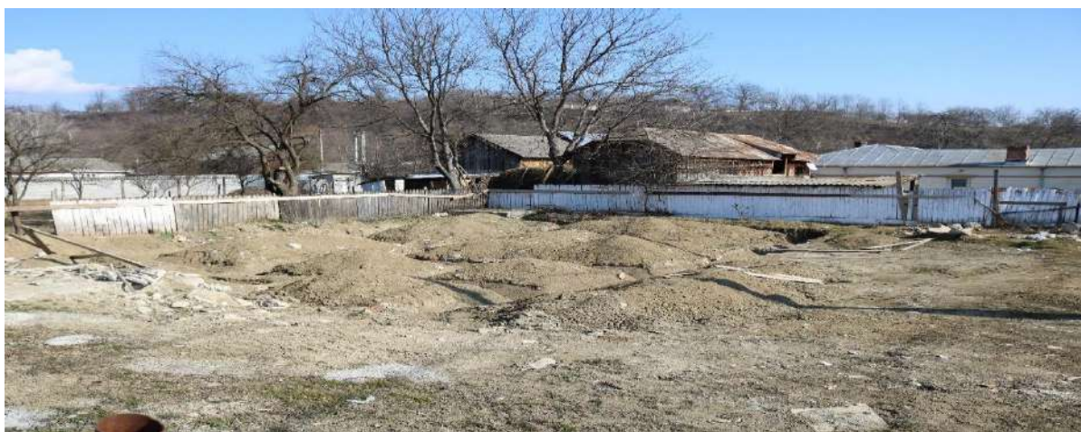
Școala Nr. 2 Vulcăneasa - În acest moment în construcție
