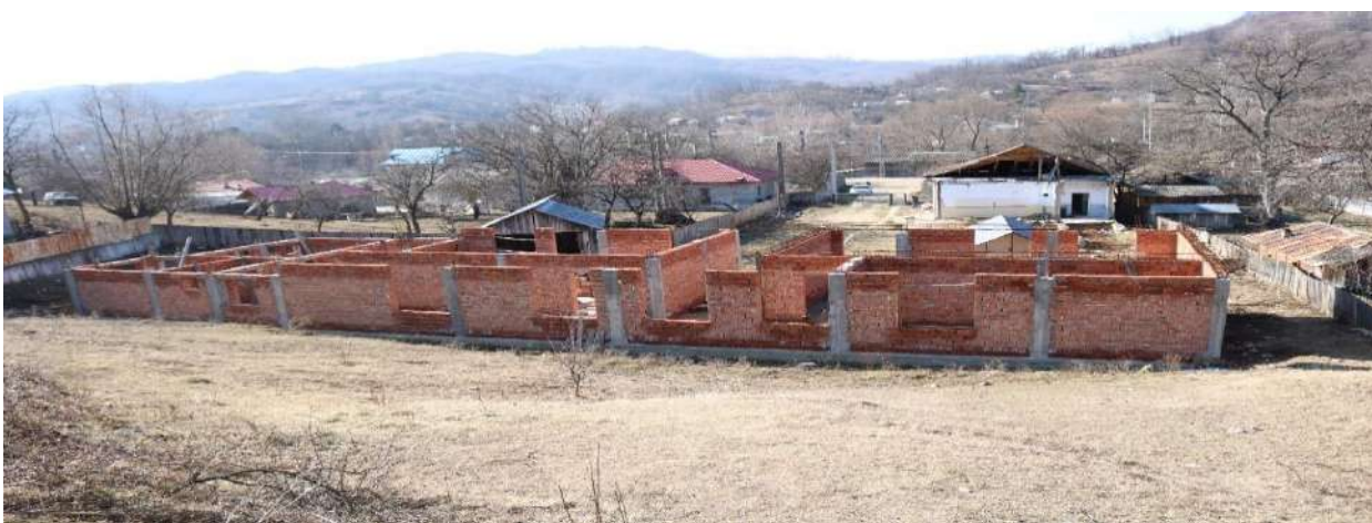
Școala Primară Livada – În construcție 2020
