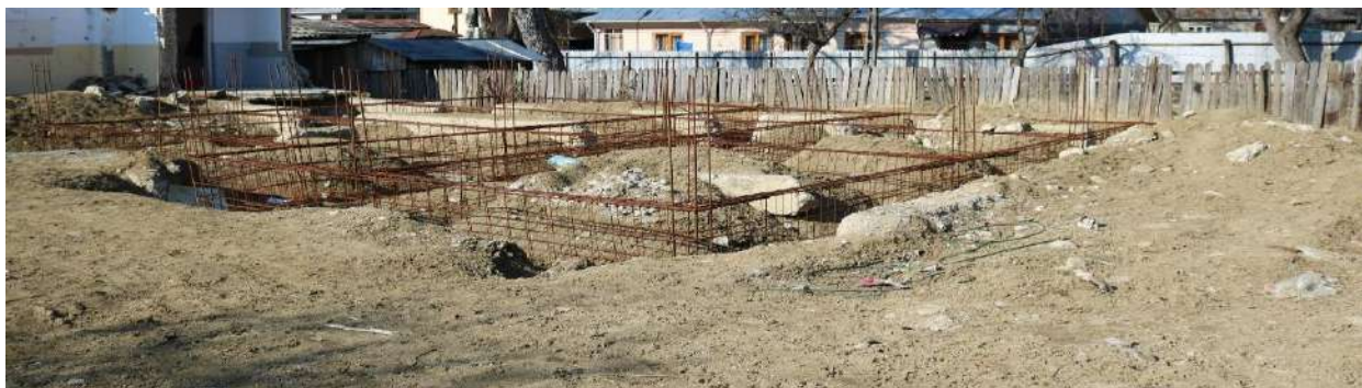
Grădinița Livada - în construcție 2020
